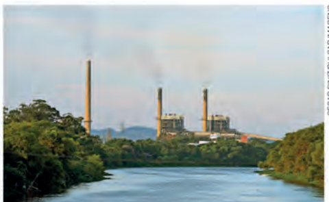
Nas usinas termoeletricas, a energia térmica, obtida pela queima de carvão, gás natural ou petróleo, é transformada em energia elétrica.
