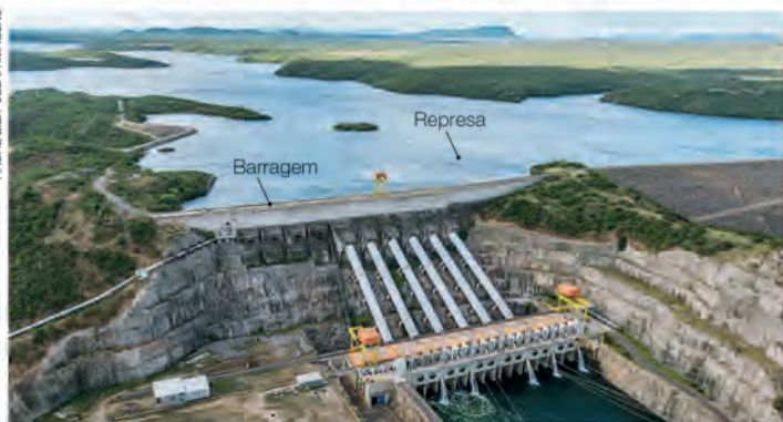
Nas usinas hidrelétricas, a água movimenta turbinas que geram energia elétrica. Vista aérea da Usina Hidrelétrica de Xingó e da barragem, que represa água do Rio São Francisco no município de Piranhas, Alagoas, 2016.
