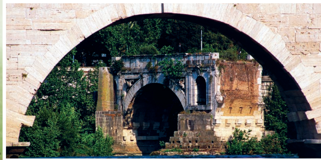
Vista da Ponte Emília, também chamada de Ponte Partida, construída no século II a.C. Roma, Itália. Fotografia de 2016.
